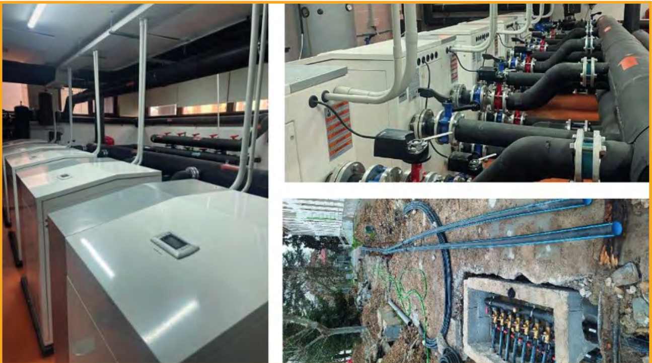
Ilustración 2. Bombas de calor geotérmicas en el campus universitario de Orense (imágenes cedidas por AFEC-ECOFORREST)
