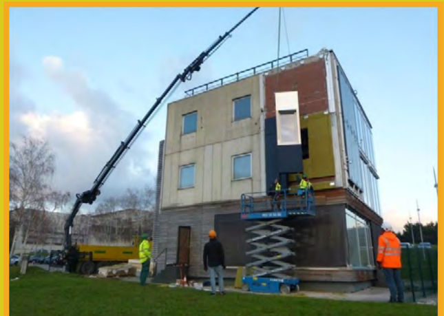
Sistema industrializado Plug&Play de rehabilitación de fachadas (imágenes cedidas por TECNALIA)
